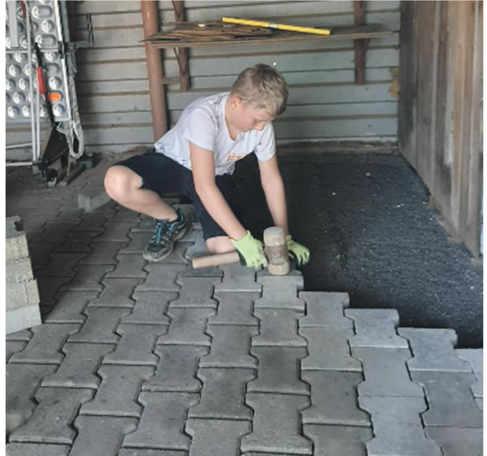
An mehreren Nachmittagen wurden von den Kindern, unter Anleitung und Hilfe von Herrn Meier Trennwände entfernt, Splitt geschaufelt, Unterbau und Frostschutz eingebracht, sowie neues Pflaster verlegt. Ein Dankeschön geht an den Bauhof der Gemeinde, der uns logistisch bei diesem Vorhaben unterstützte.
