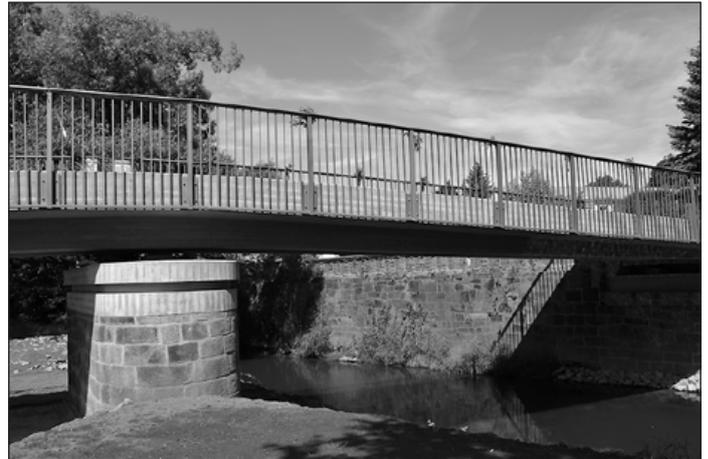
Umfassend erneuert wurde es 1899, davon zeugen die Steine des Mittelpfeilers. Die Brücke ist nun im Unterbau weiterhin ein Denkmal, aber im Überbau ein modernes Bauwerk. Die Zweifeldbrücke stützt der belassene, alte Pfeiler. Im Scheitelpunkt ist sie jetzt einen Meter höher. Im Hochwasserfall soll das Schäden vermeiden, so auch ein Verfangen von Treibgut. Nun bleibt zu hoffen, dass die alte, neue Brücke sehr, sehr lange hält und die Menschen sicher vom einen zum anderen Ufer bringt.
