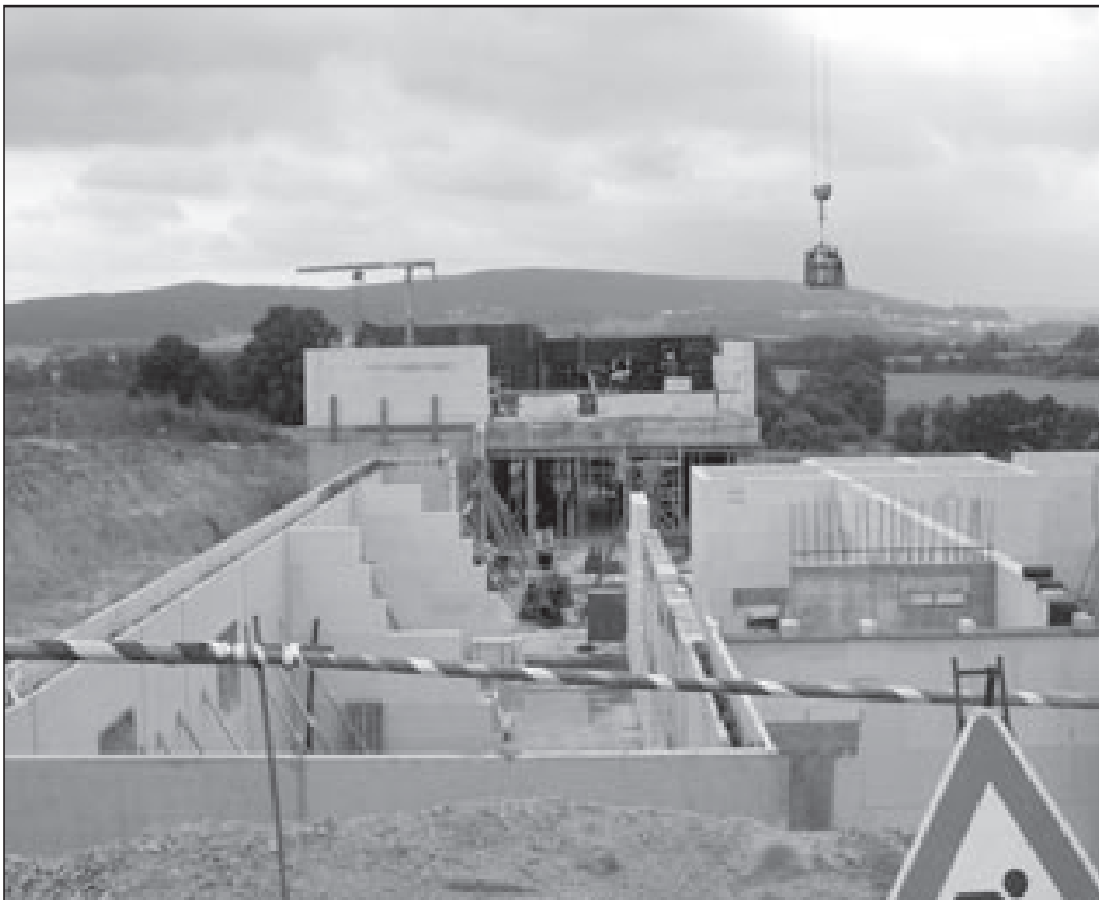
Stand der Bauarbeiten im Juli 2007
