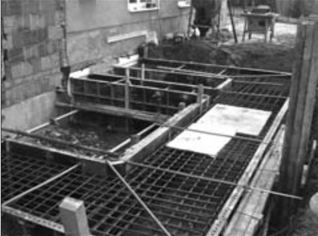
**Fundamente vor dem Betonieren**
